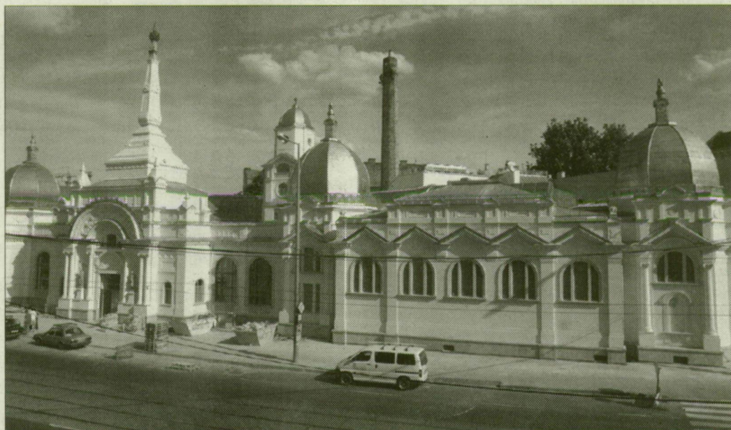
Kivágták az épület elől a fákat, ám újakat telepítenek ide
