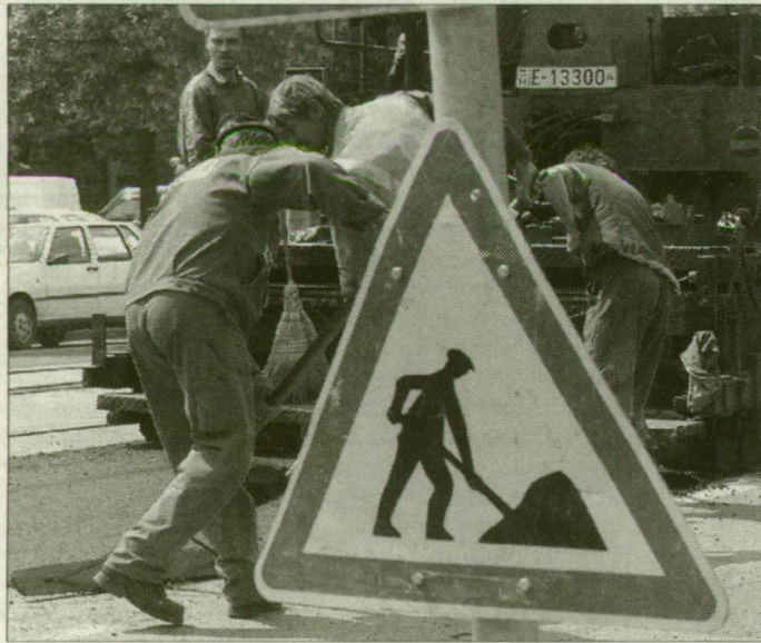
Aszfaltozás a Kossuth Lajos sugárúton
