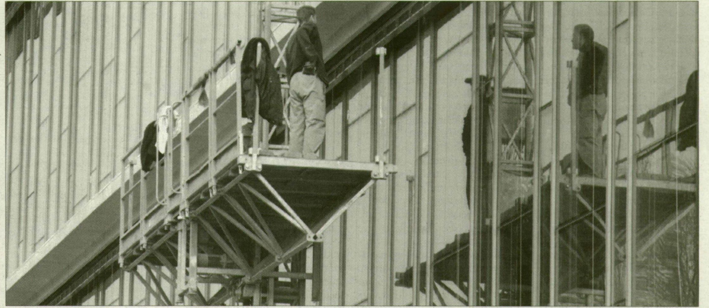
Látványos munkát végeznek az Ady téri épület homlokzatán
