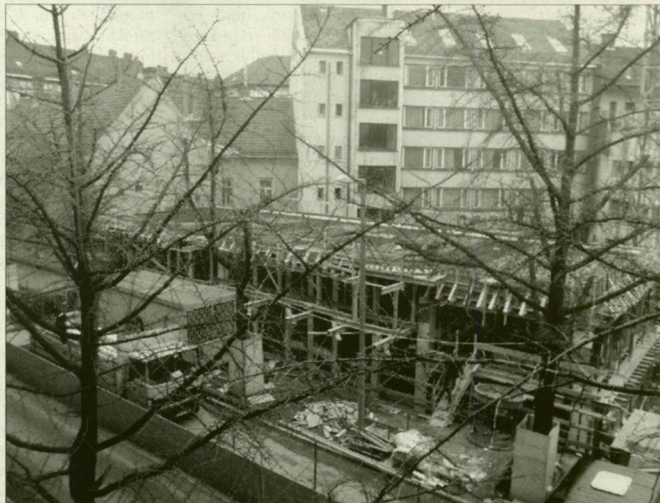
Beszorítva is jól haladnak a 28 lakásos társasház építésével
