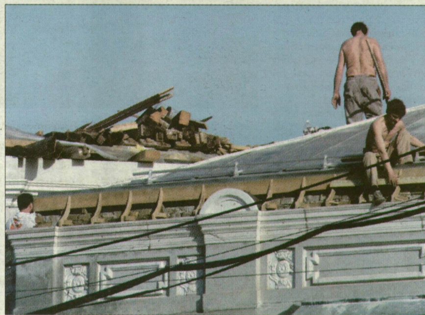
A főbejárat melletti kupola újjáépítését, ahol a gerendák látszanak, az eredeti megrendelésből kifejejtették
