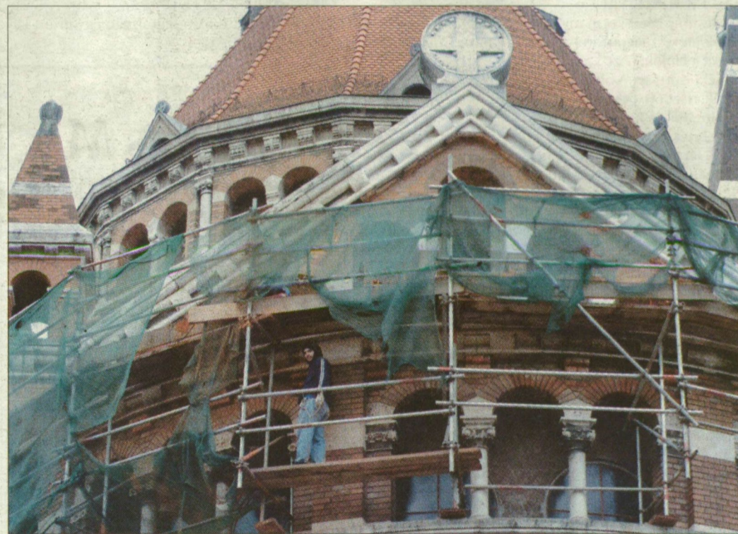
A szentély középső ívén is fölüújítják a tetőszerkezetet
