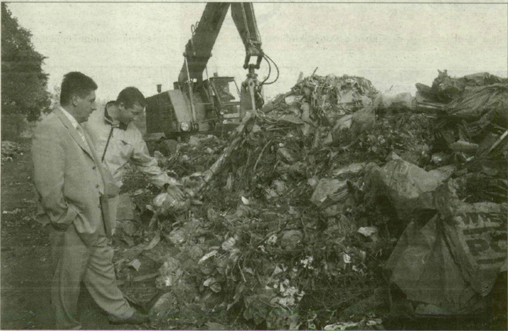
Öt teherautó két műszakban hordta a hulladékot.
