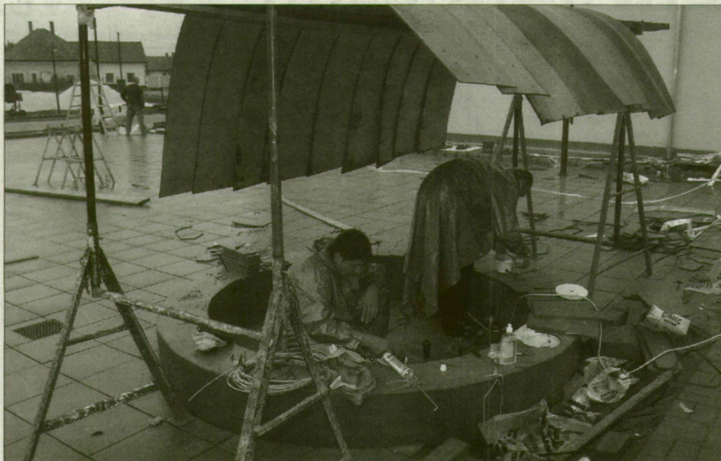
A szökökút díszvilágítását szerelik az esőben.
