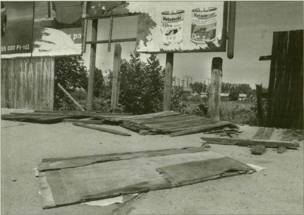
Leszakadt kerítés, mögötte pedig gaztenger csúfítja a volt fatelepet.
