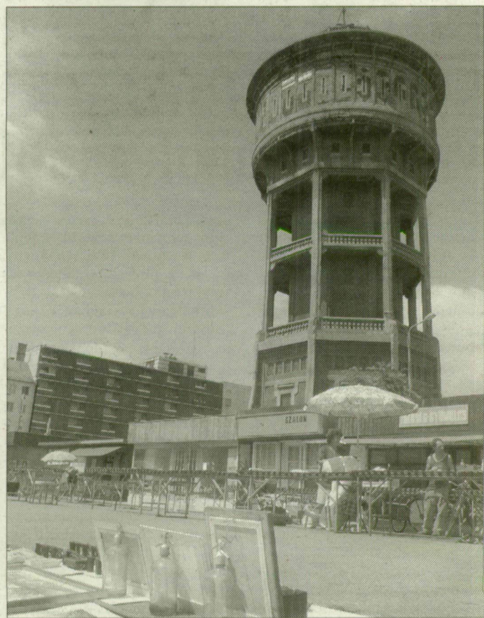
A torony felújításához 400 millió forint kellene. Fotó: Schmidt Andrea
