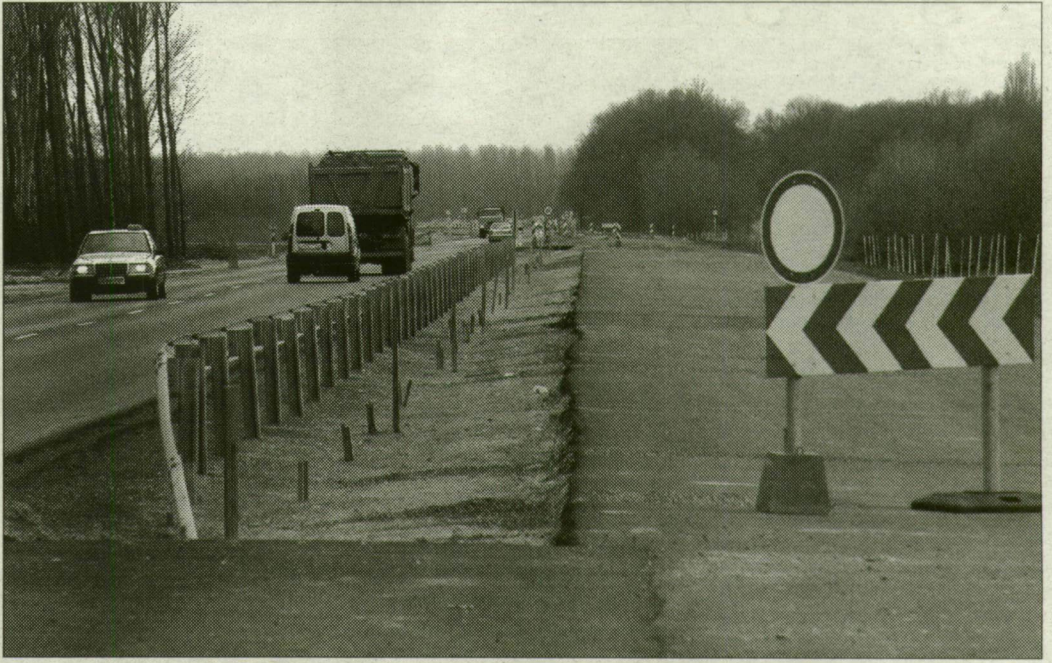
Nyárra befejezik a munkát a 47-es főút algyői híd és Kopáncs közötti szakaszán.
