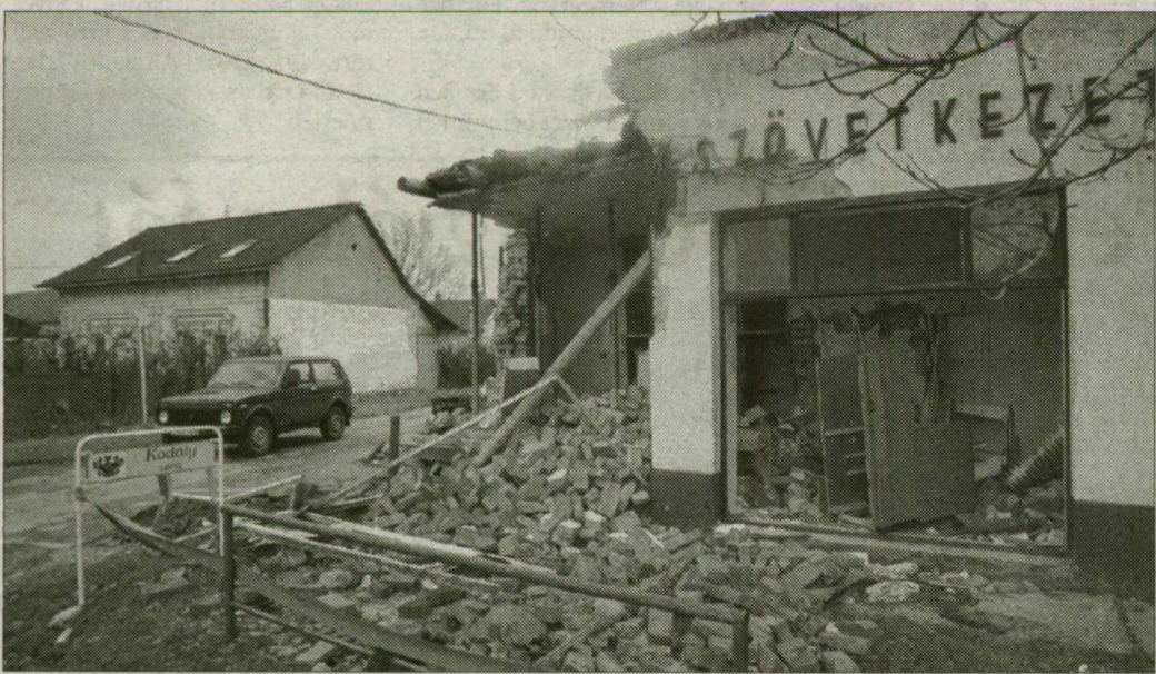
A teherautó becsapódásától megrongálódott épületrészt aládúcolták.
