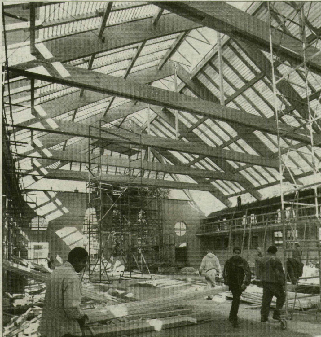
Belső munkák a Radnóti épülő tornacsarnokában.
