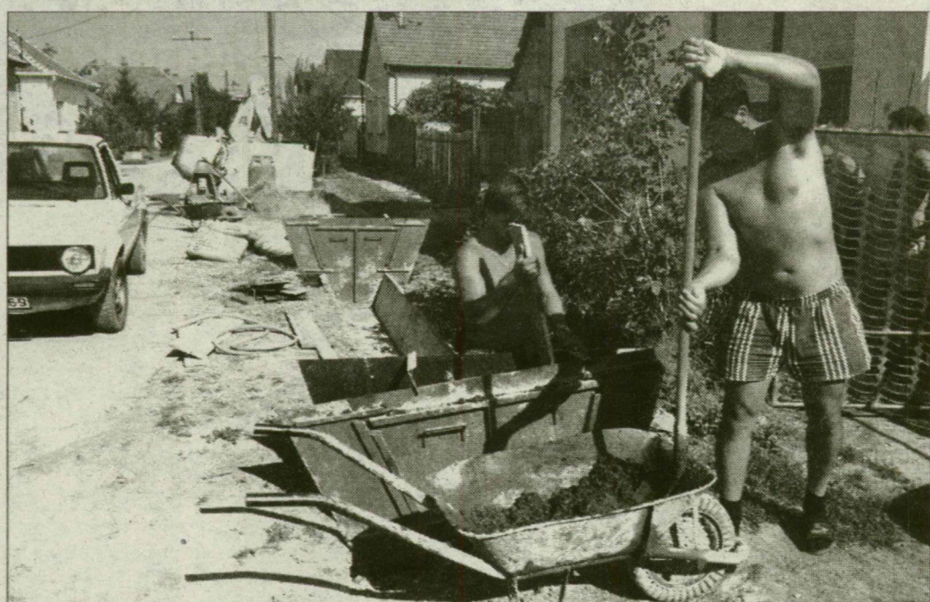
Szőregen most a csapadékvíz-elvezető árkok építése a legnagyobb feladat.
