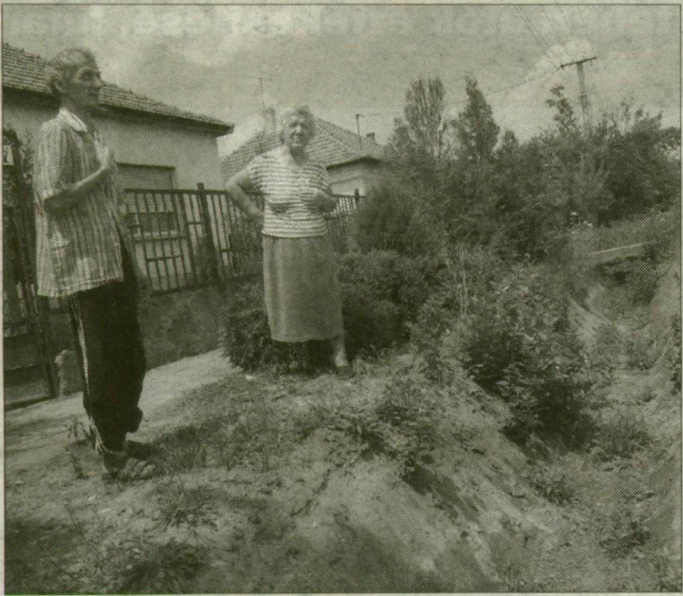
Az idős, betegeskedő Virág házaspárnak a lakhatását is nehezíti a kapubejárót kettészelő árok.
