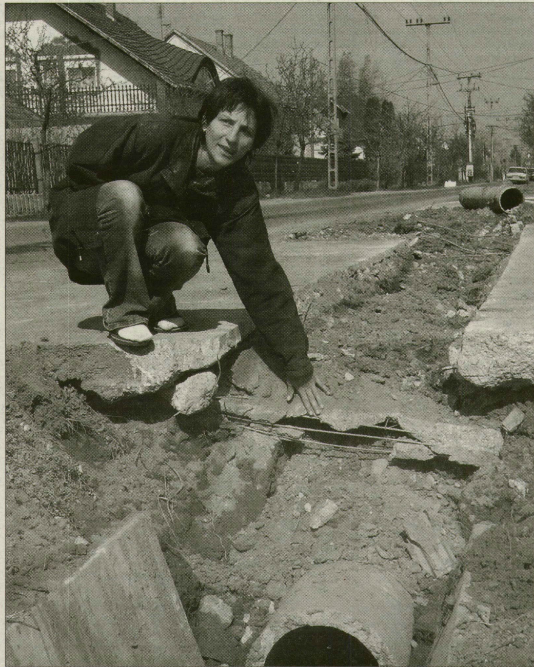
Elválták a merevítőrudakat, a vékonyka beton pedig hamar elrepedhet – mutatja Szűcsné Hegedűs Zsuzsanna, a béketelepi mindenés.
