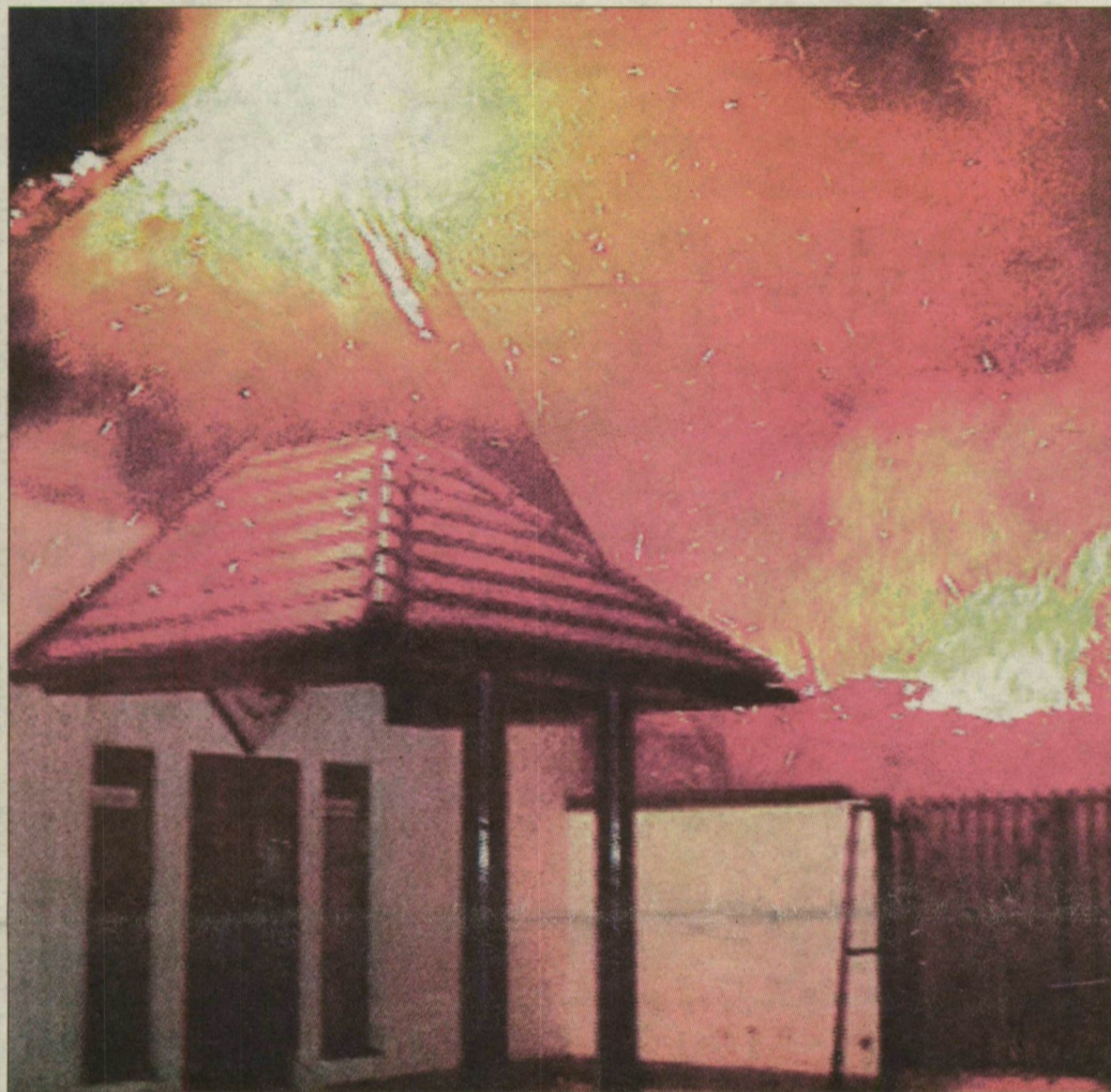
A diszkó tetőszerkezete a tűzoltók értesítésekor már teljes egészében égett.
