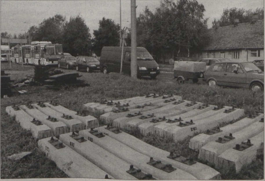
Beépítésre váró „talpfák” az út mentén. (Fotó: Karnok Csaba)
