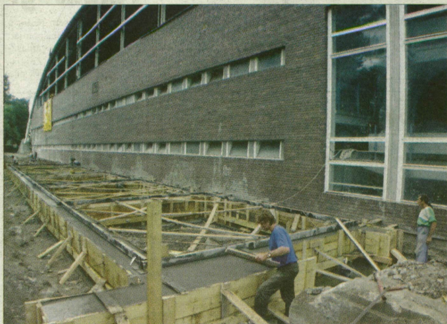
A KÉSZ Kft. már a cölöpalapozásnál tart az újszegedi Sportcsarnok rekonstrukciós munkálataiban. (Fotó: Karnok Csaba)
