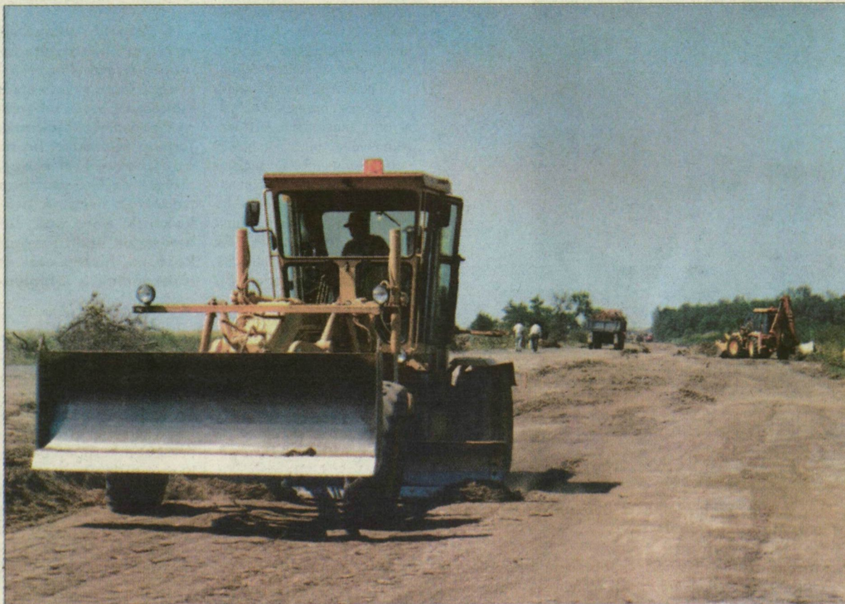
Az útépítést az uniós ellenőrei is rendben találták. (Fotó: Schmidt Andrea)
