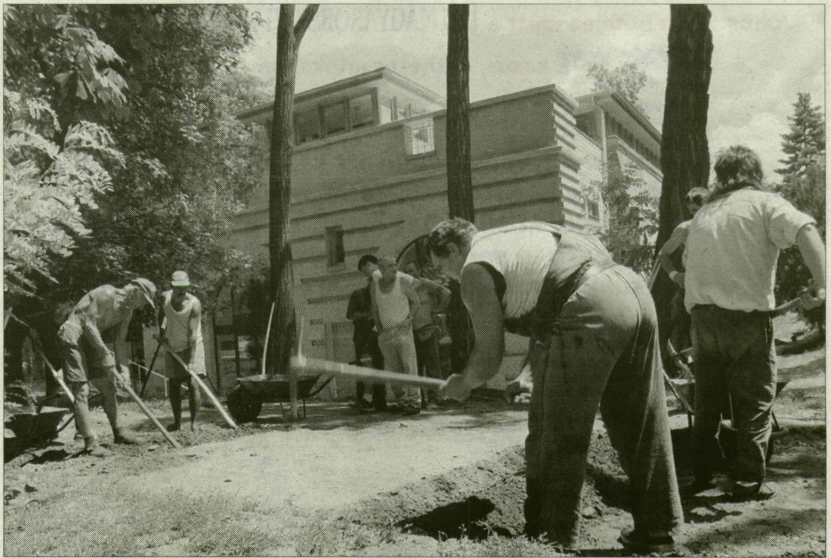
Tegnap elkezdtek a térburkolat alapjainak kibontását a vár délnyugati oldalán. (Fotó: Miskolczi Róbert)
