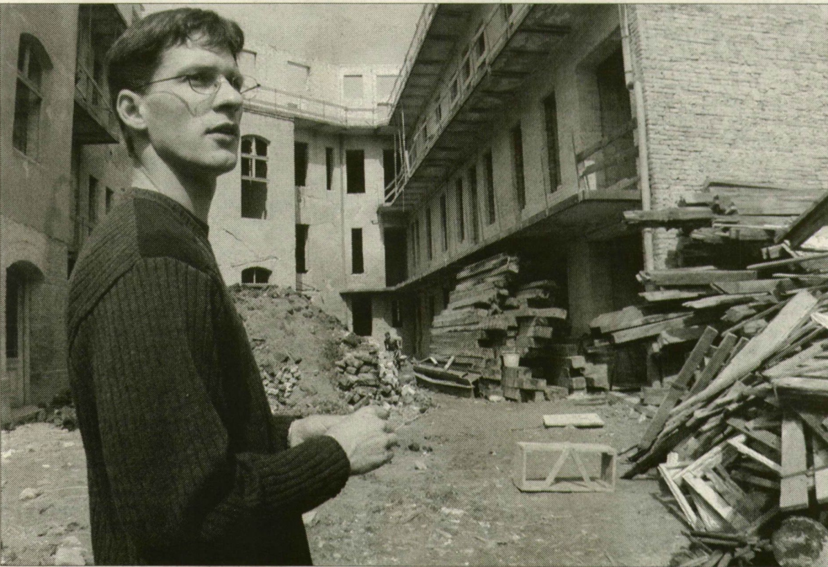
A bontást már elkezdték a Bors-palotában. Az építési engedélyt jövő hétre várják. (Fotó: Karnok Csaba)
