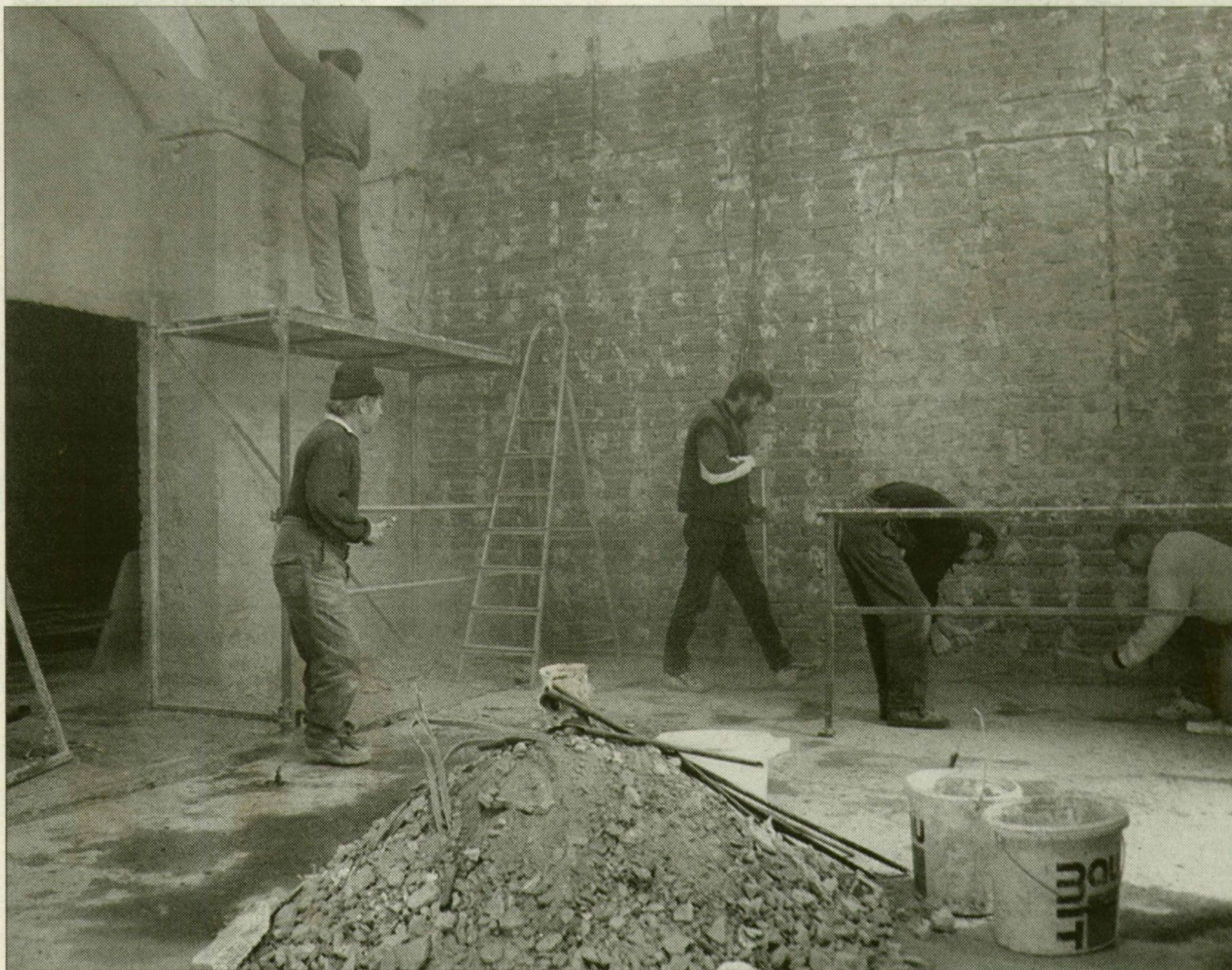
Virág-felújítás. Kávéfőző gép helyett most a kőműveskalapácsoké a terep. (Fotó: Miskolczi Róbert)
