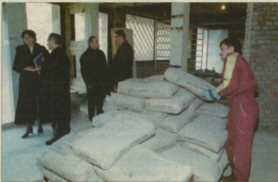
Vezérkari vizit a szálloda építkezésén. (Fotó: Karnok Csaba)
