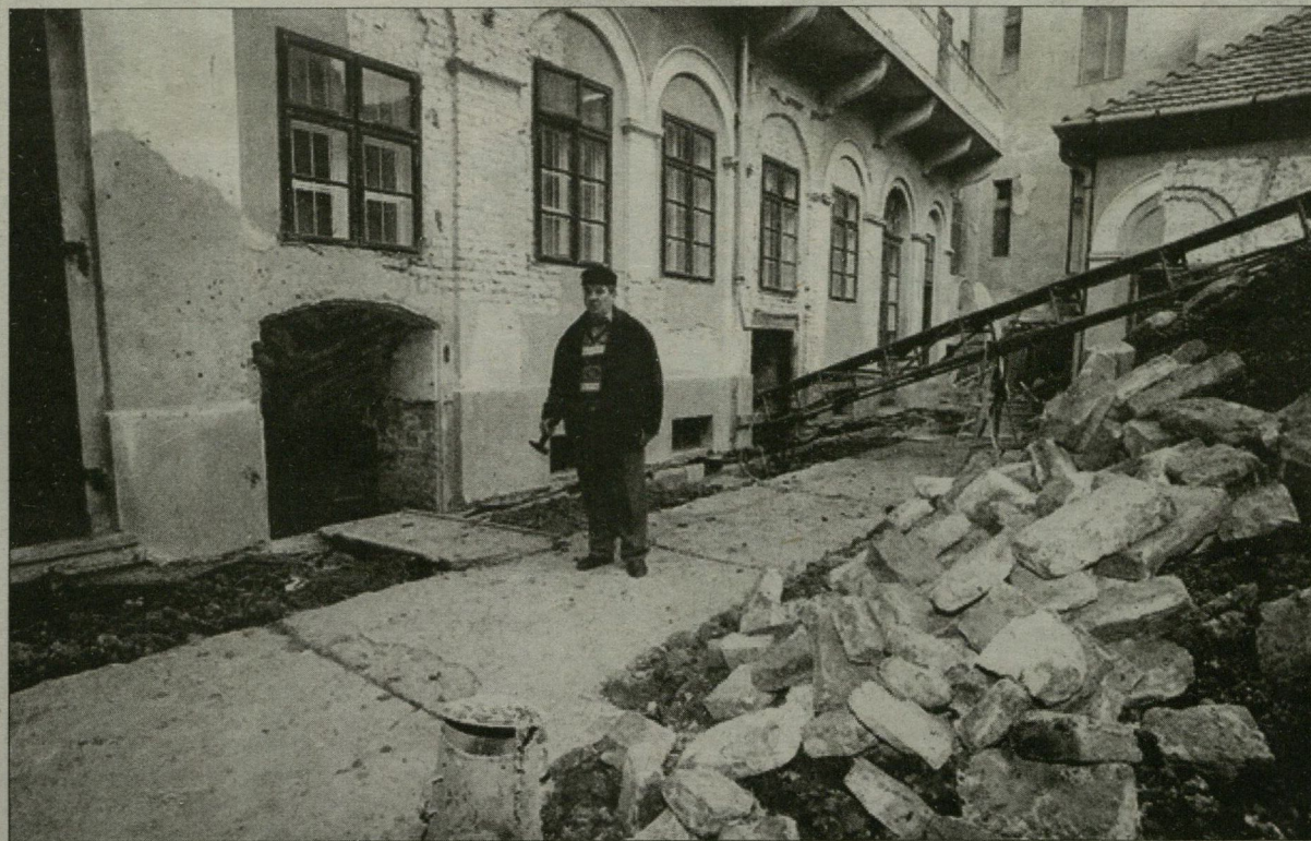
A pince padlószintjét másfél méterrel lesüllyesztették. (Fotó: Nagy László)
