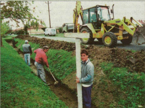
Az algyői faluház melletti terület közművesítése már elkezdődött. (Fotó: Gyenes Kálmán)
