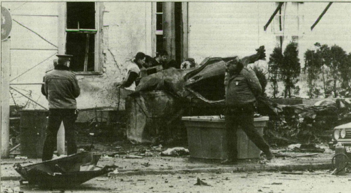
Tájkép, robbantás után. A tettesekről még ma sincs semmi hír... (Fotó: Karnok Csaba)
