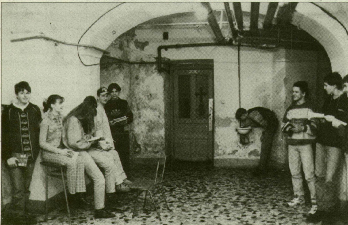
A Radnóti gimnázium épülete néhol alapos felújításra szorul... (Fotó: Miskolczy Róbert)
