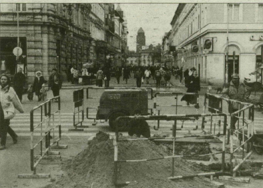
A száz évvel ezelőtt épített csatornarendszerhez most, a tisztítás alkalmával készítik el az aknákat. (Fotó: Nagy László)
