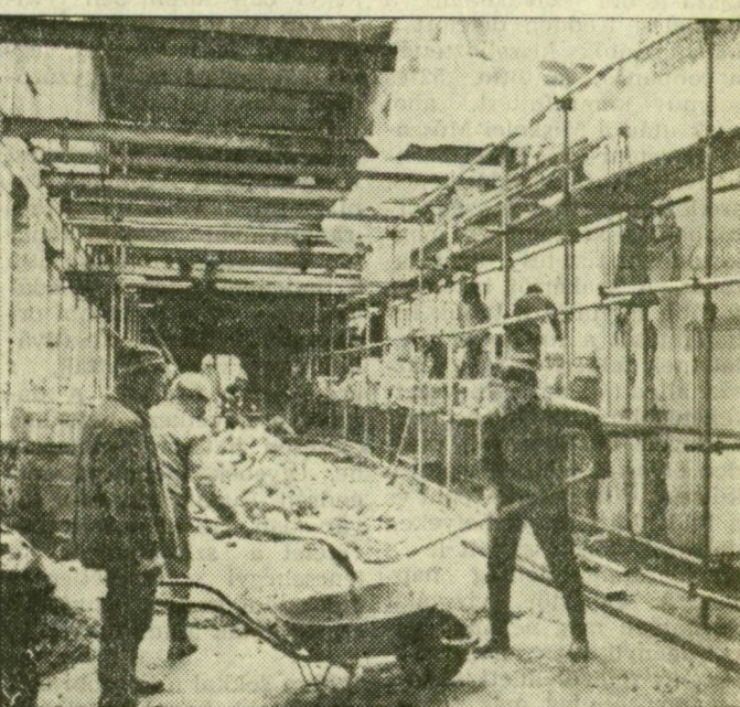
Falaznak, előregyártott födemeleket építenek be — már az első emeleten is
