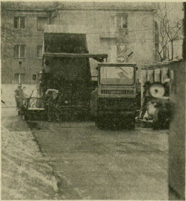
Rekordidő alatt készült el az útburkolat javításával a város helyi Közútépítő Vállalat Szegeden, a Dózsa György utcában. A két napig tartó munka alatt a járművek zavartalanul közlekedhettek, nem volt forgalomterelés. Így is lehet!
