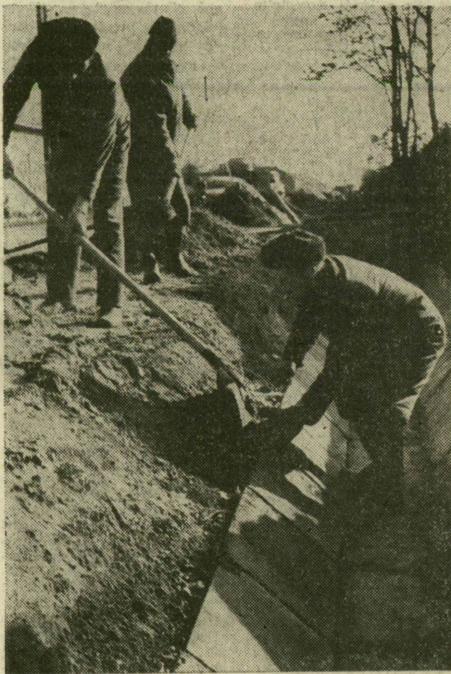
Forráskút főutcáján készül a nyíltszelvényes csatorna. A novemberi tél akadályozta a munkát, a fagymentes napokon azonban teljes gözzel dolgoztak a Kiskunmajsai Vízgazdálkodási Társulás dolgozói
