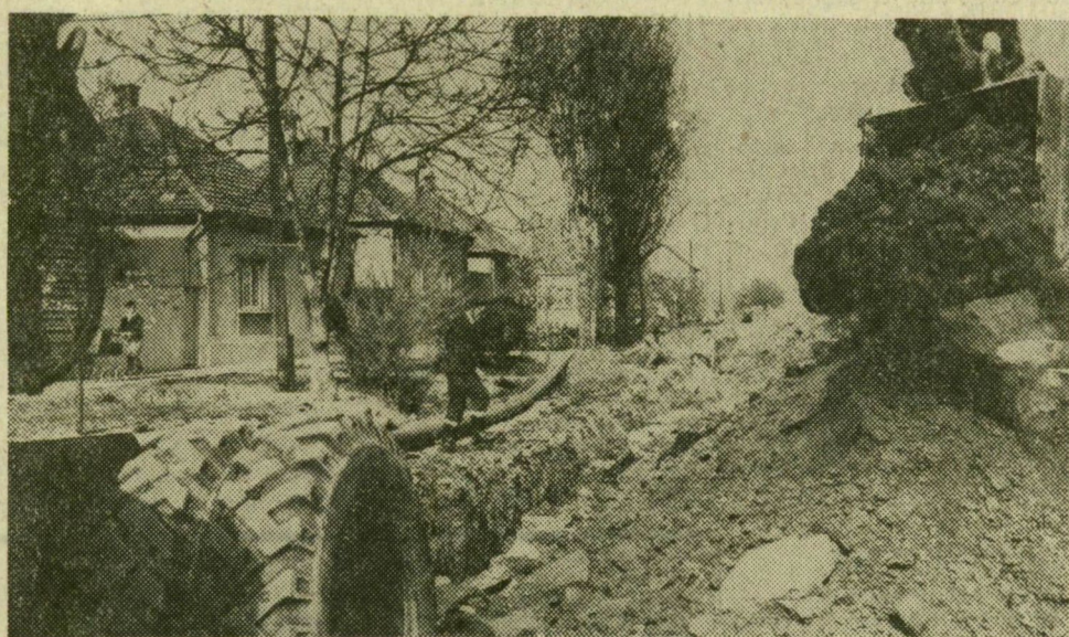
Épül a gázvezeték
