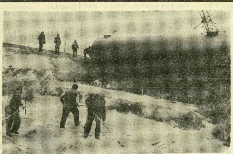
Tegnap, kedden emelték helyére a Szőregen épülő AFOR-üzemanyagtöltő állomás három, egyenként 50 köbméteres tartályát, miután a gödör kiképzését és alapozását befejezték. Képeinken az első beemelését örökítették meg, a Szegedi Magas- és Mélyépítőipari Vállalat dolgozóinak munkáját
