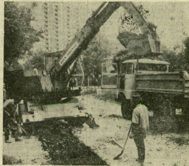
Újszegeden, a Bérkert utcán a közműeket is felújítják
