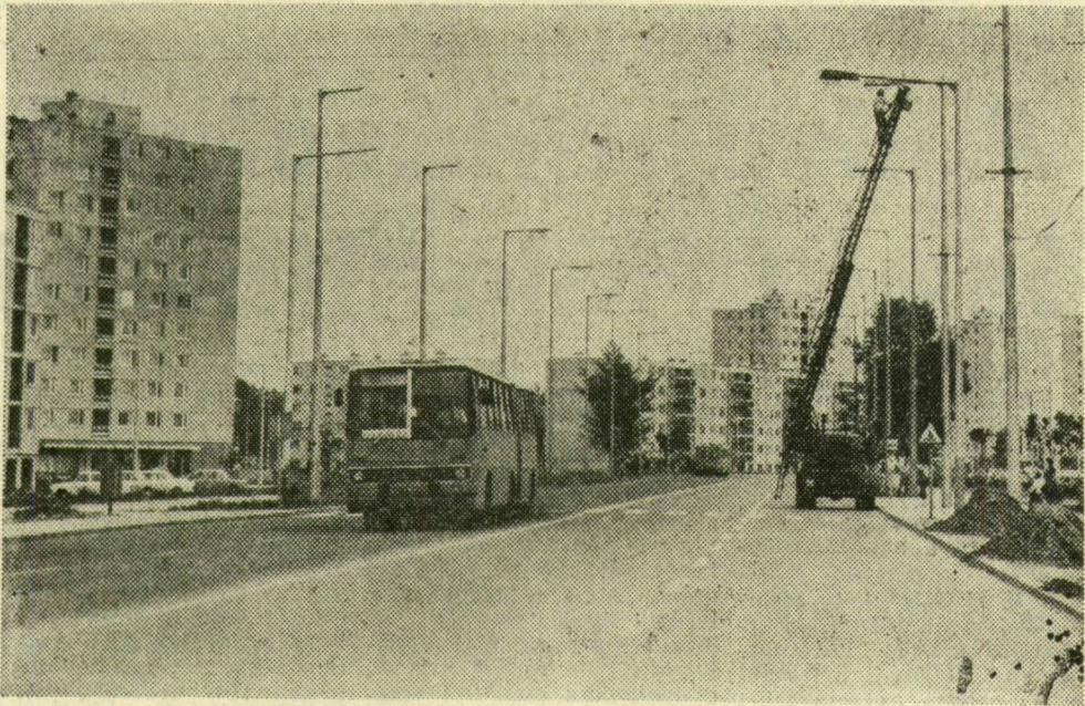
Nagy fényerőű higanygőzzókat szerelnek föl Szegeden, a Csongrádi sugárúton elhelyezett új lámpaoszlopokra. Az eddig használatos 250 wattos izzók helyett újabban 400 wattosakat alkalmaznak, s ezek viszonylag gazdaságosabban is üzemelnek a régieknél. Képzünk az Északi városrészben készült, ahol a DEMÁSZ Che Guevara szocialista brigádjának tagjai dolgoznak
