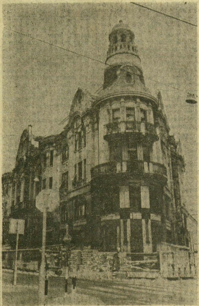
Kerítések és „fres” ablakszemek jelzik: újabb épülettel gyarapodik majd a felújított házak sora
