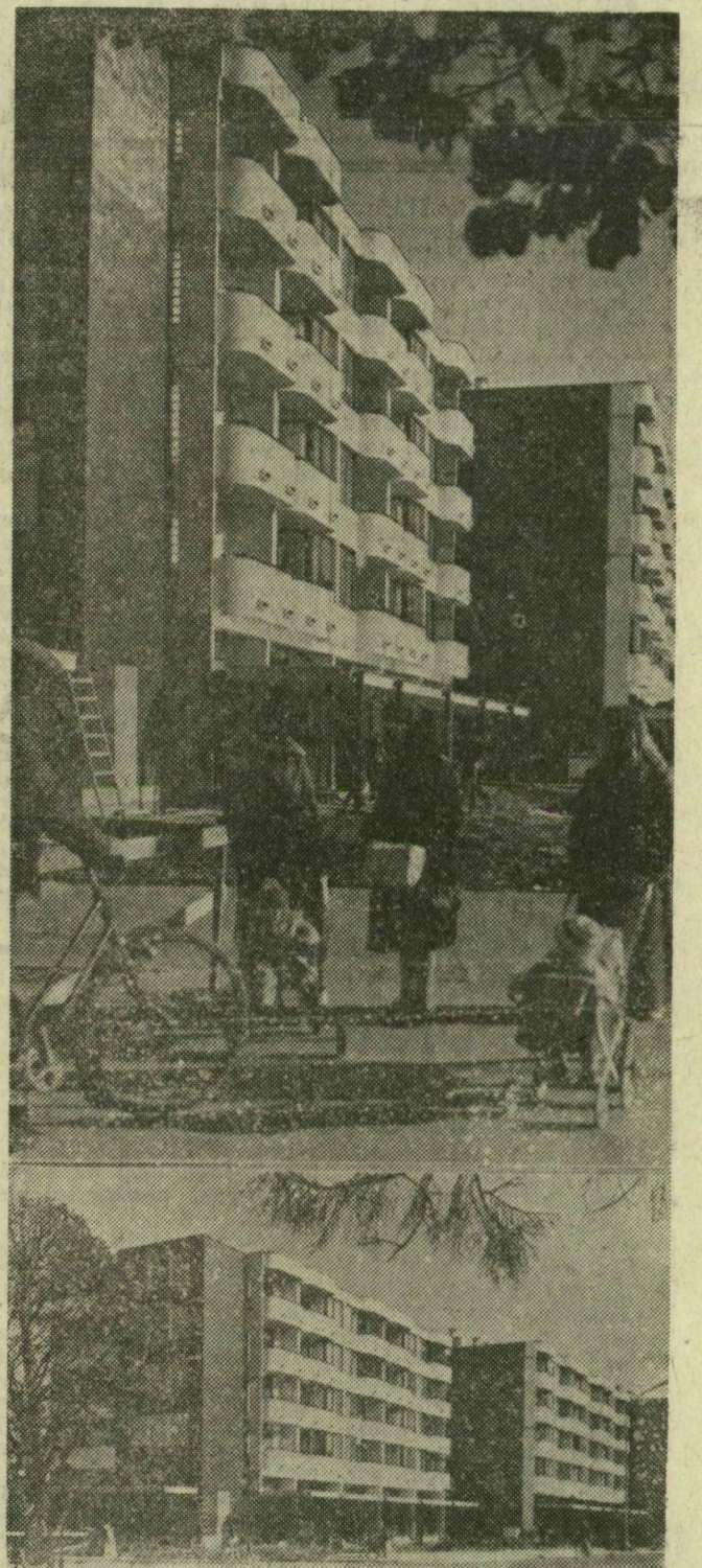
Szentesen átadták a főutca rekonstrukciójának új épületét, amelyben 64 lakás, számos üzlet és szolgáltató kap helyet. Az épület öntött beton technológiával épült. Sebők József (CSOMITERV) tervei alapján
