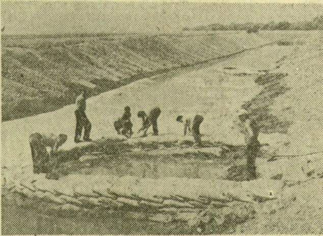
Homokzsákok közé zárták a csipkési buzgárt
