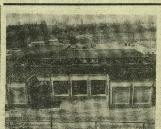
Számítógéppont épül az Északi városrészen a CSOMIEP kivitelezésében az Építészgazdasági és Szervezési Intézet számára. Az új épületben helyezik majd üzembe a nagy teljesítményű R-22 számítógépet. Képünkön: Az új intézet madártávlatból.
