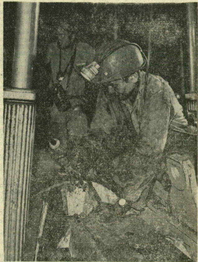
A Mecseki Szénbányák üzemeiben a műszaki fejlesztési program eredményeként számos új technológiai eljárás és technikai berendezés segíti a munkát. A komló Kossuthbányán — képkönn — egy lengyel fejtejszobiztosítási berendezéshez szovjet gyártmányú — marótárcsás — jövesztőberendezést építenek
