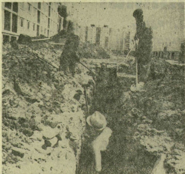
A Felsőváros II-es ütemének lakásait jelentős részben már átadták. A házak között azonban még mindig akad tennivalója a DÉLÉP munkásainak. A csatornák, közművek kialakításán dolgoznak az építőipari munkások. A lakótelepi építkezésnek ezt az utolsó mozzanatát örökítette meg fotóriporterünk. Képünkön: a Sallai Imre szocialista brigád tagjai ássák a csatornát
