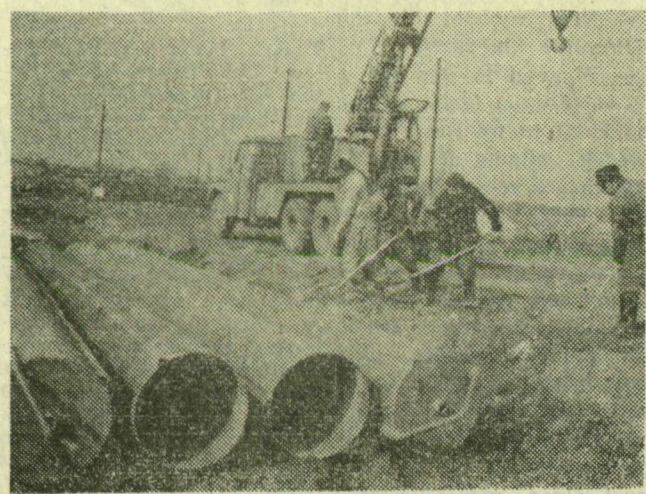
A csöveket már az építkezéshez szállították
