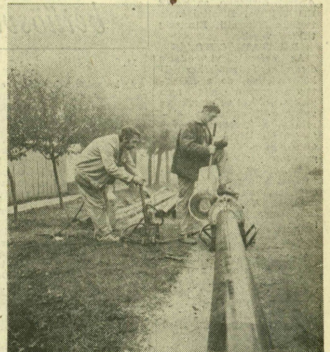
Acs S. Sándor felvételei A megolvadt végeket 20 atmoszféri nyomással prüsszelik össze
