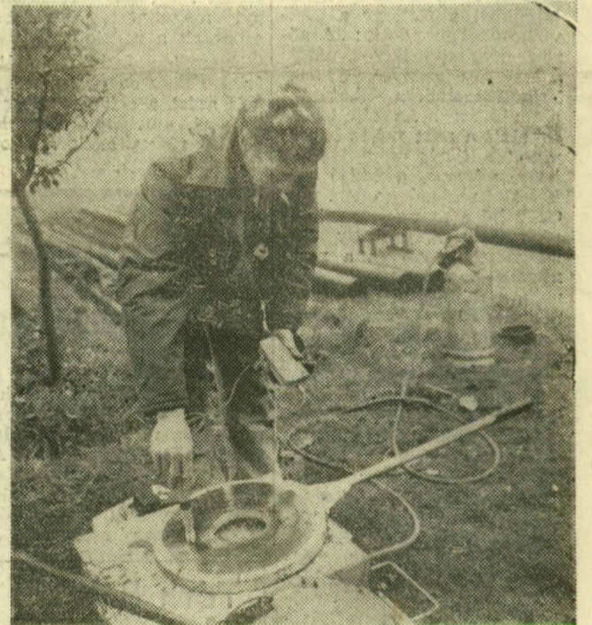
A hegesztéshez szükséges hőmérsékletet a hevítőtárcsán műszerrel ellenőrzik
