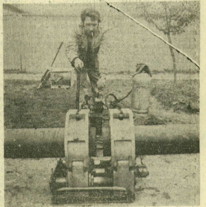
A magasnyomású prüsszel állítják megfelelő távolságra a vezetékcsöveket
