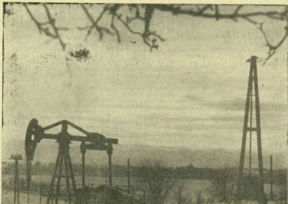
A nagylengyeli kőolajmezőben most épültek meg a szénsavas másodlagos művelés bevezetéséhez szükséges üzemi kísérletek felszíni berendezései. Képünkön: mélyszivattyúhímba a nagylengyeli olajmezőben
