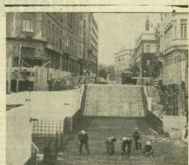
Épül Budapesten, a Jászai Mari téri, valamint a Frankel Leó úti gyalogos-aluljáró. Szerelik az alapelem vasszerkezetét és szigetelik az aluljáró fűdém szerkezetét. Harminc vállalat összehangolt munkája szükséges ahhoz, hogy november végére befejeződjön a Margit-híd százkilencvenmillió forint értékű felújító munkája. Képünkön: a Frankel Leó úti aluljáró vasszerkezetének szerelése
