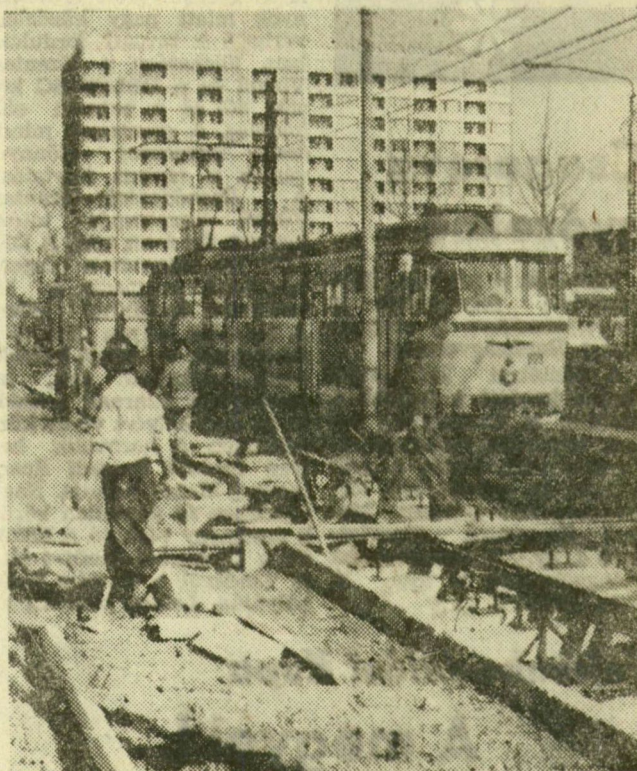
Somogyi Károlyné felvétele Három vállalat dolgozó építik az új vágányszakaszt a tarjáni végállomáson
