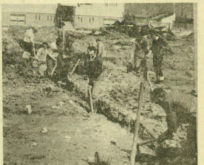
Somogyi Károlyné felvétele. A majdani parkot öntözni is kell, az árokba fektetik le majd a vízvezeték
