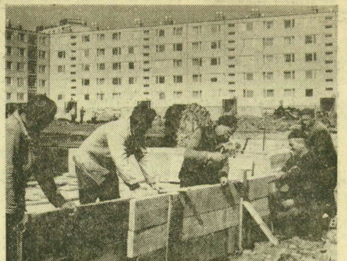
Buknits István szocialista brigádja (DÉLÉP) virágtartó betonozásához készíti a faszaluzatot
