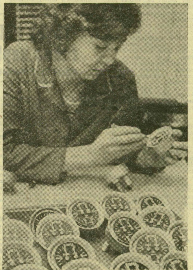
Az Óra- és Műszeripari Szövetkezet évente 140 ezer darab manométert készít. Ezeket a műszereket többek között az Ikarus-autóbuszokba, a Láng Gépgyár kazánjaiba, valamint a Ganz-MÁVAG berendezéseibe építik be. A szövetkezet az orenburgi gázvezetékhez is szállít műszereket. Képünkön: Szerelik a manométereket
