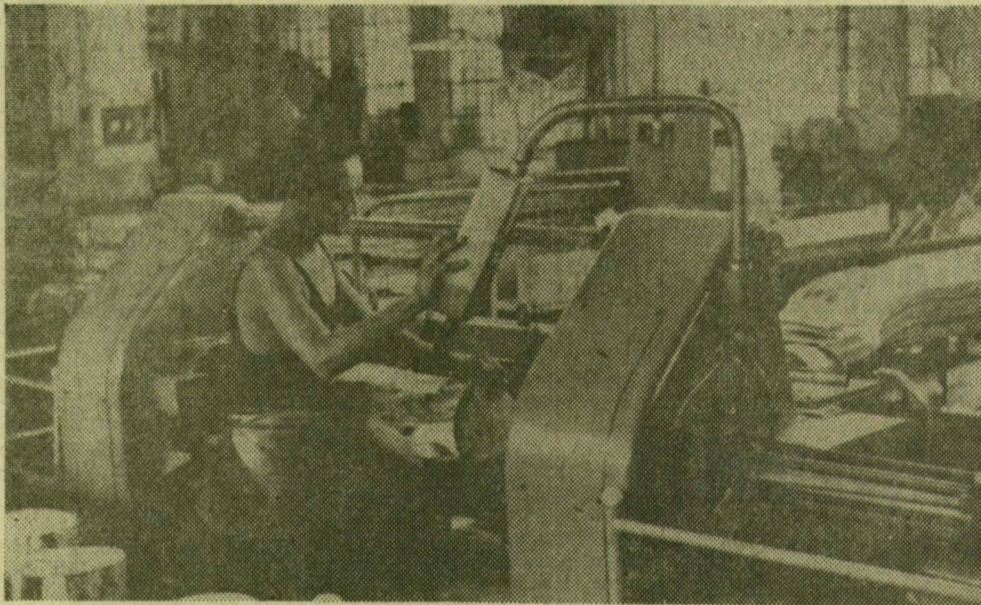
Automata vezérlésű gép hámozza a rönköket
